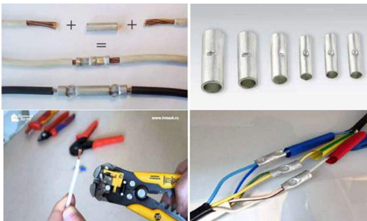
Рисунок 4.7 – Опресування за допомогою гільз (втулок)
