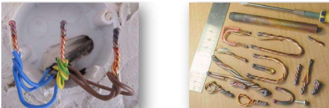
Рисунок 4.4 – З'єднання проводів зварюванням
