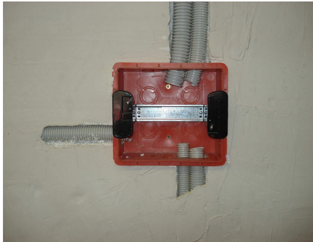
Рисунок 2.1 – Система прихованої проводки “Октопус”
