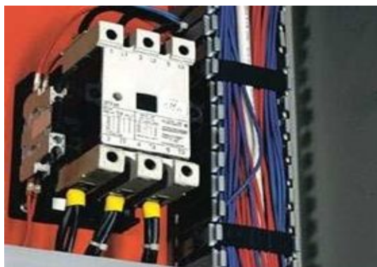
Рисунок 2.7 – Кабеленесуча система та комутаційні елементи “QUADRO”
