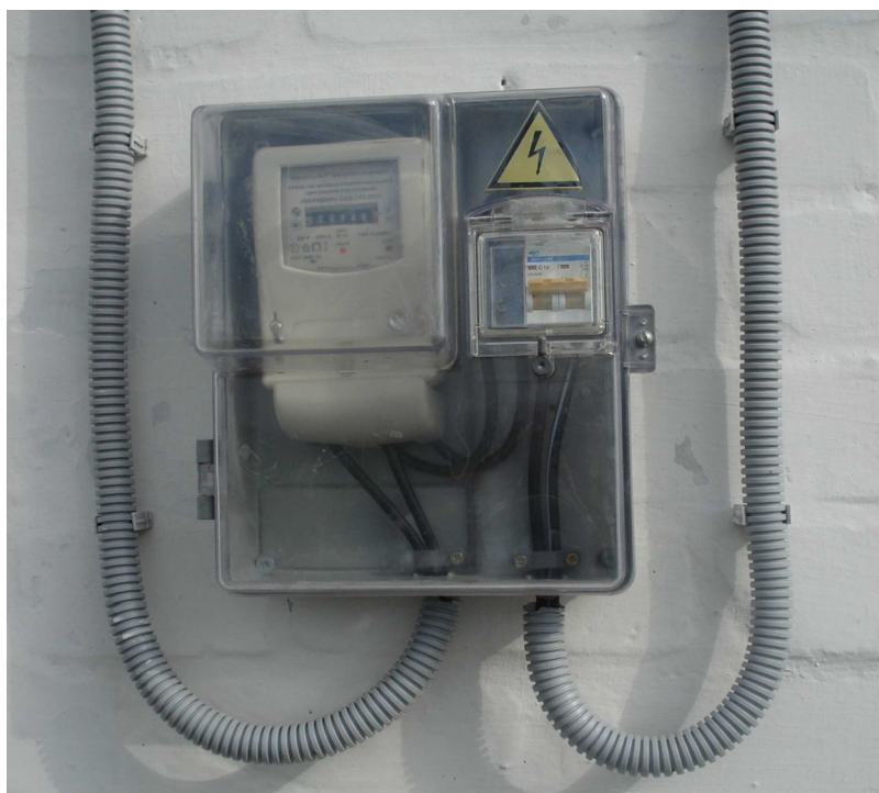
Рисунок 2.18 – Встановлення лічильника електричної енергії на ввіді в будинок
