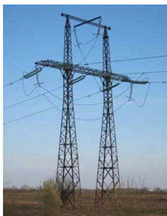
а) транспозиційна опора лінії 110 кВ
