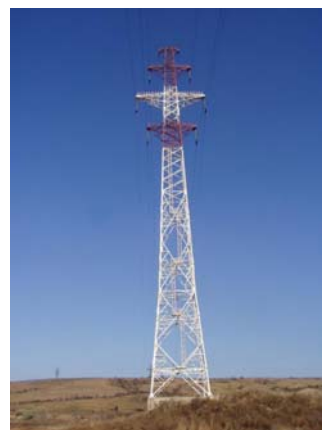
в) перехідна опора лінії 110 кВ
