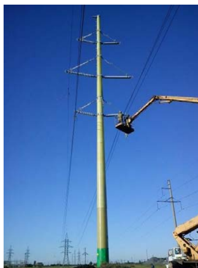
Рисунок 2.26 – Проміжна композитна опора повітряної лінії 110 кВ
