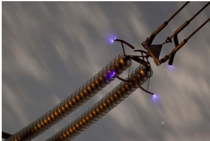
Рисунок 3.6 – Коронний розряд на конструктивних елементах повітряної лінії
