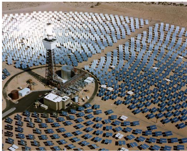
Рисунок 2.7 – Сонячна електрична станція баштового типу
