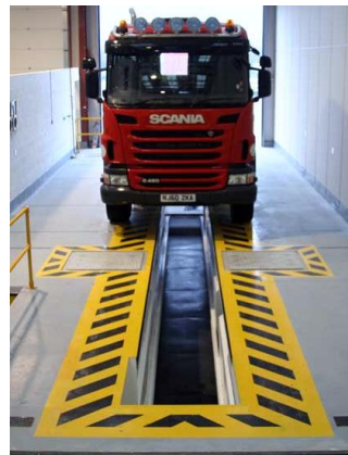
INSPECTION PIT /m'spekʃ(ə)n pɪt/ ОГЛЯДОВА КАНАВА
