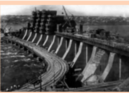
Будівництво Дніпровської гідроелектростанції. 1930 р.
